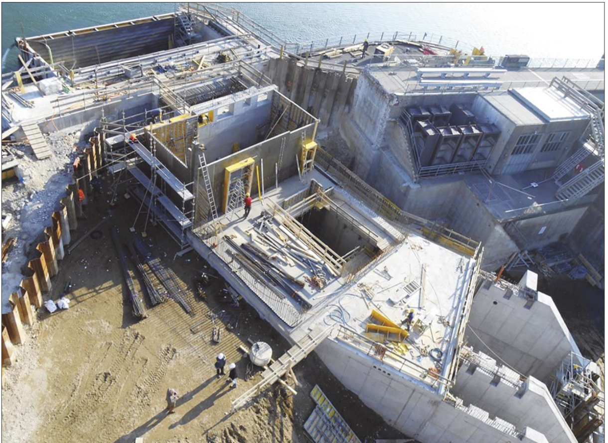
Wehr Thurnsdorf – Betonarbeiten Krafthaustiefhochbau
