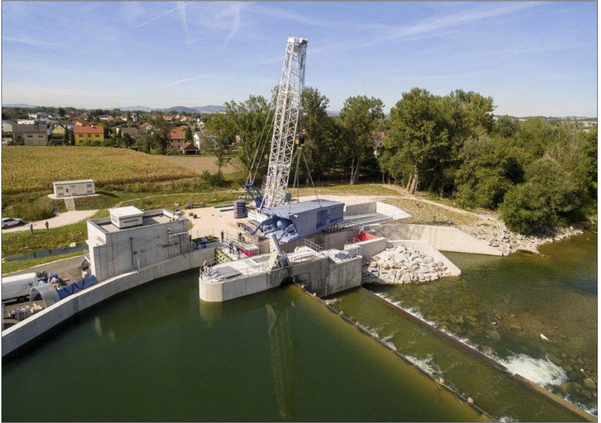
Kraftwerk Enns – Einheben der HSI-Maschine
