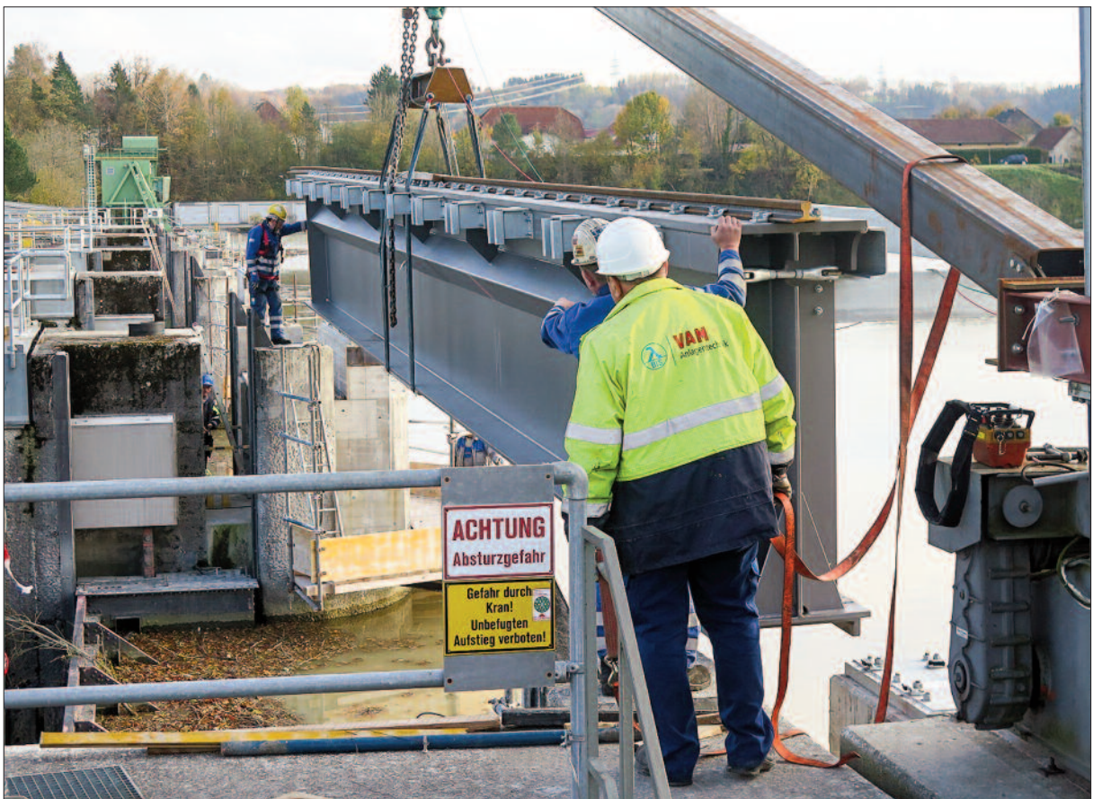
Kraftwerk Stening – Einheben neuer Kranbahnträger
