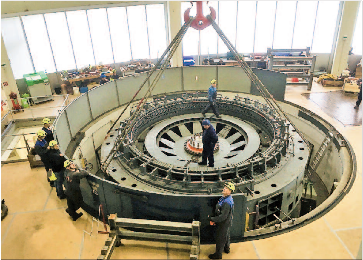
Kraftwerk Weyer – Statormontage
